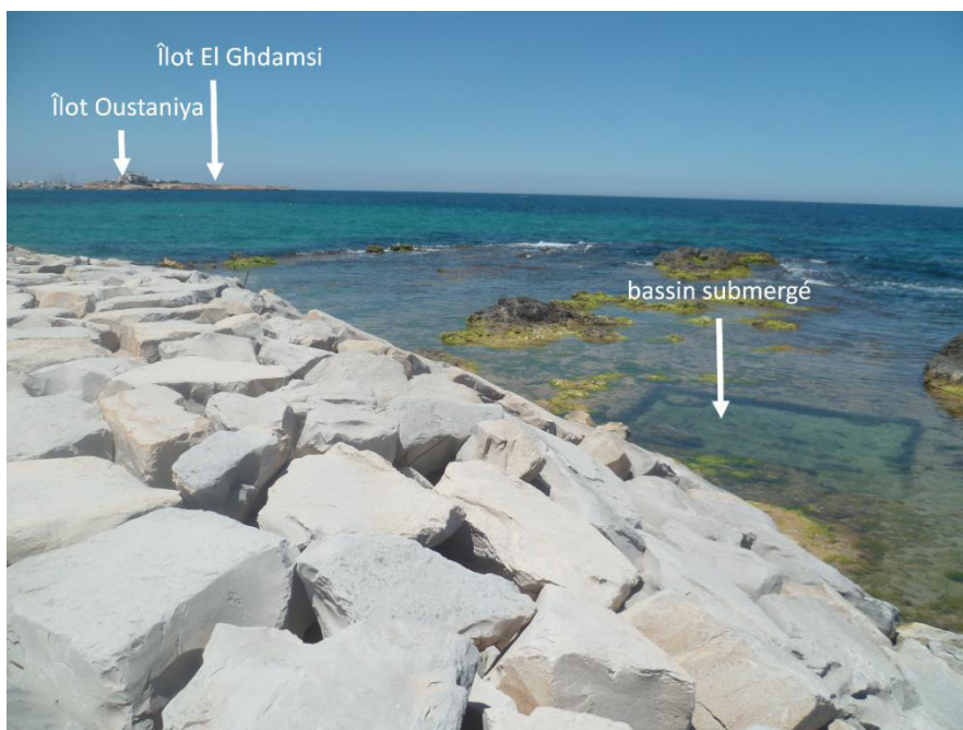
Figure 7- L'une des cuves submergées interprétées comme viviers à poisson antiques. La photo est prise par marée basse. D'autres bassins ont été couverts par l'enrochement.
