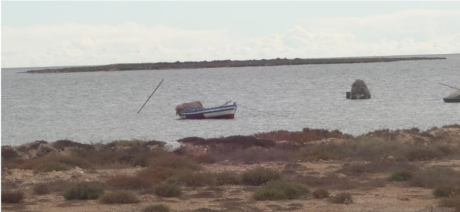
Figure 3 - L'îlot El Far, vu depuis le promontoire de RassEddzira, au premier plan, le matériel caillouteux provient des ruines. Il est accumulé au bord de la mer comme forme de protection, par les paysans, contre le recul de la microfalaïse.
